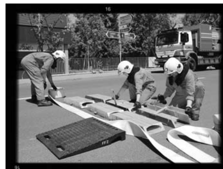
Schlauchverlegen auf einer Hauptstrasse.
